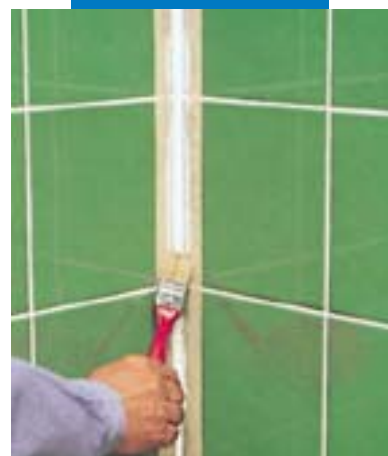
Lissage du joint avec de l'eau savonneuse
