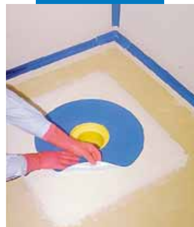
Positionnement de la pièce prédécoupée de Mapeband sur Mapegum WPS
