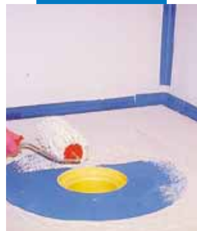
Mapeband est noyé dans Mapegum WPS
