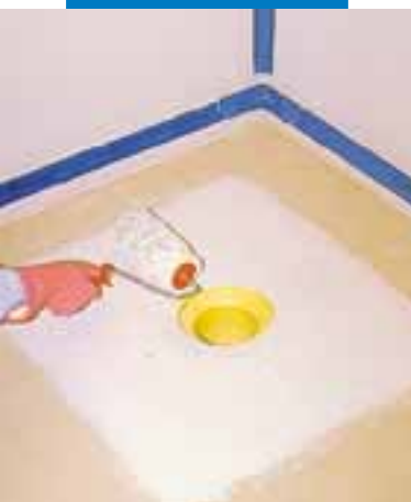
Application de Mapegum WPS à proximité d'un siphon de douche
