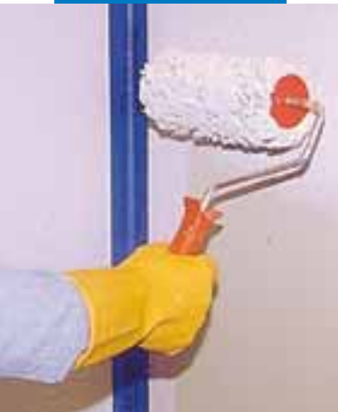
Application au rouleau de Mapegum WPS en mur
