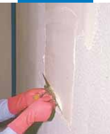
Application d'un adhésif sur Mapegum WPS
